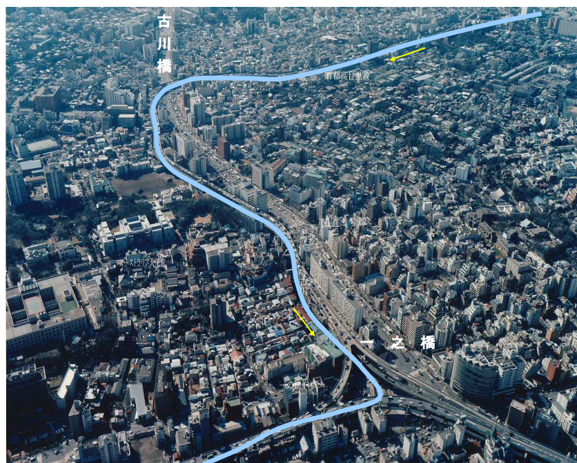
写真1-1 古川（古川橋～一之橋付近）空中写真
