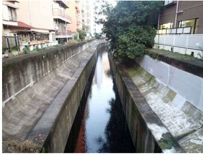
写真 2 - 4 渋谷川（山下橋付近）河川整備状況
