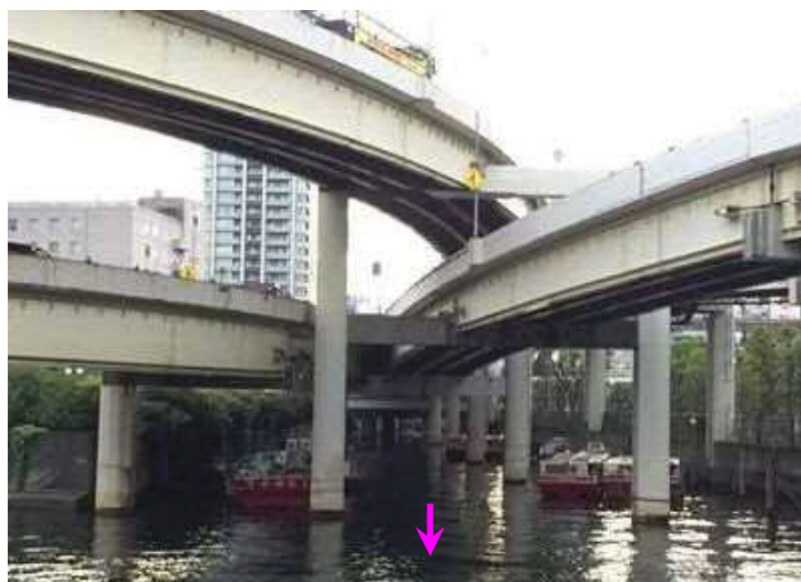
写真4-6 河口付近 現況写真 (防潮堤は改修済)
