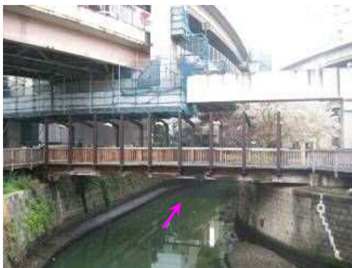
写真4-4 一之橋公園 現況写真
