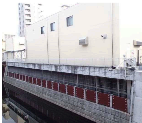
写真 2-8 養老橋下流右岸取水口
