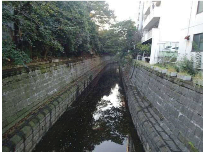
写真 2 - 5 古川（天現寺橋付近）整備状況
