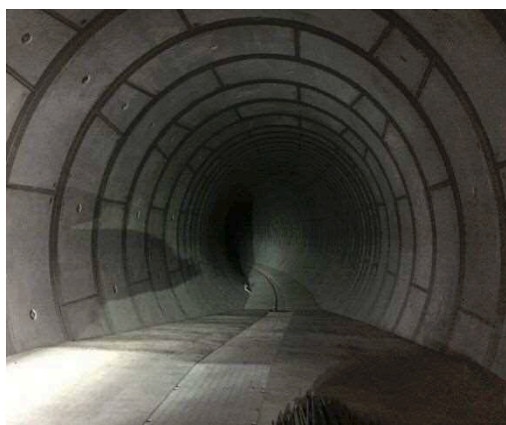
写真 2-7 古川地下調節池内部
