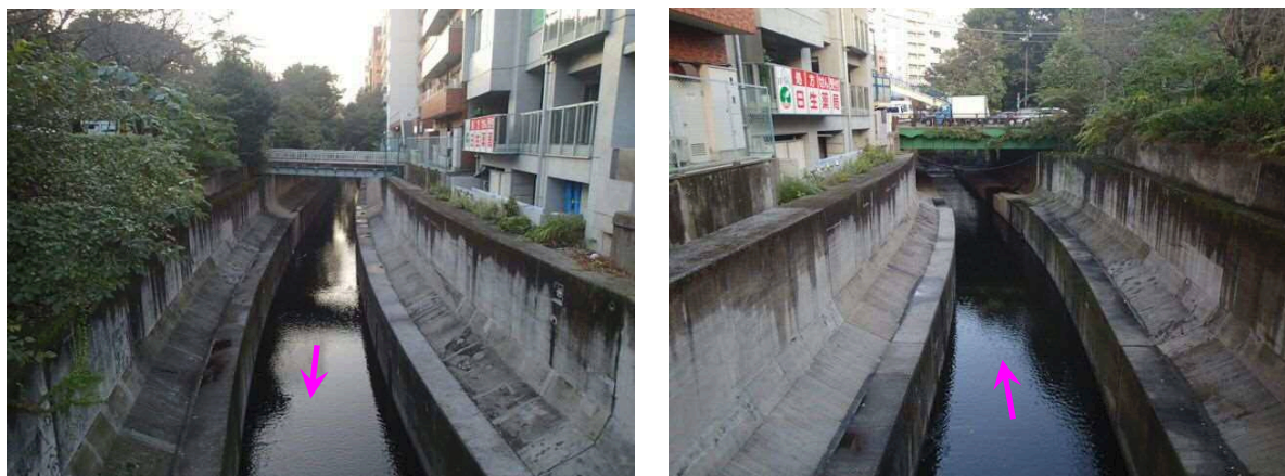
写真4-1 広尾病院付近 現況写真
