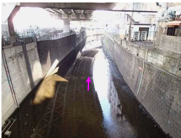
写真4-2 新古川橋付近 現況写真
