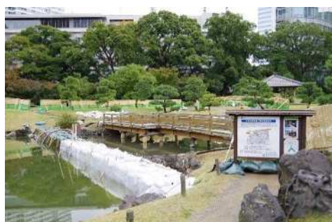
図 3-13 木橋（調査中）① （平成 29 年）
