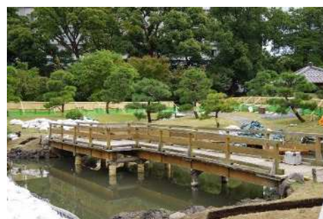
図 3-14 木橋（調査中）② （平成 29 年）
