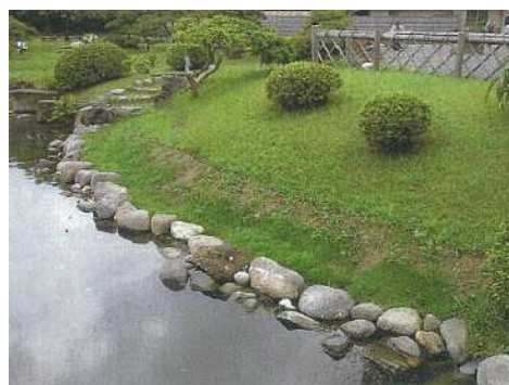
図 3-12 小池護岸（修復後） （平成 22 年）
