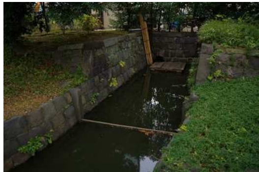
図2-100 海水取入口跡 (平成29年11月20日)
