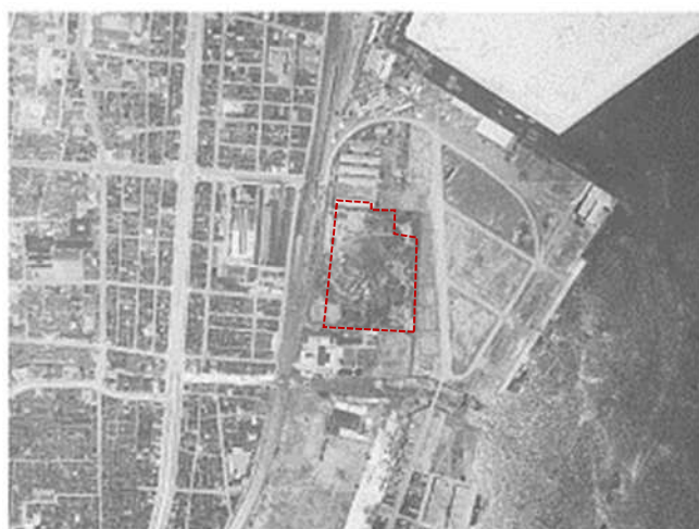
図2-37 航空写真による埋立地の状況 航空写真 昭和11（1936）年撮影 国土交通省国土地理院所蔵
