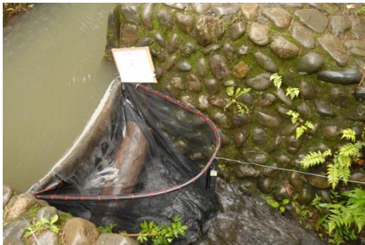
写真2 流出防止ネット
