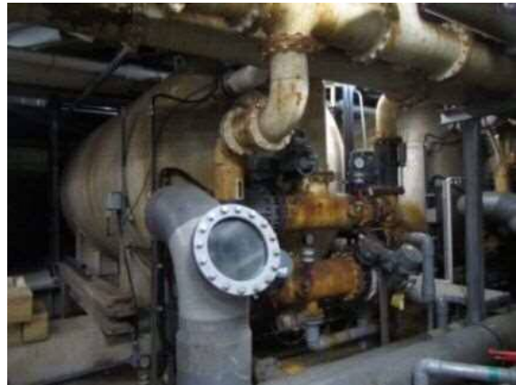
＜交換可能な配管部材のみ更新した例＞
