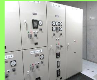
受変電設備(高圧受電盤)
