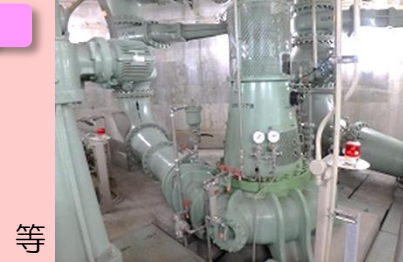
排水設備(主排水ポンプ)
