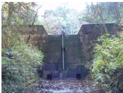
図2 坂沢 砂防堰堤
