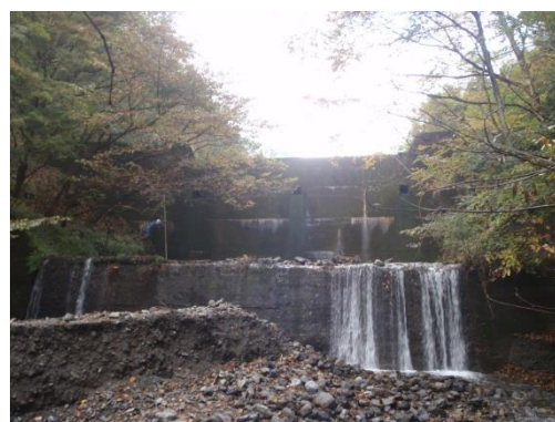
図3 峰入川 砂防堰堤
