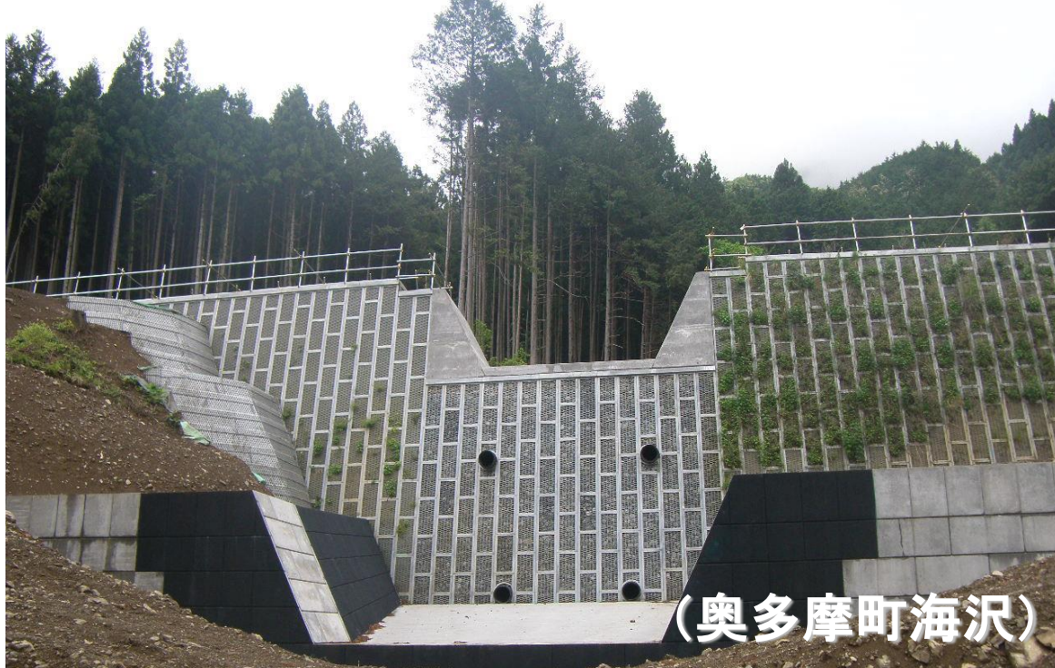
土石流を抑える砂防えん堤
