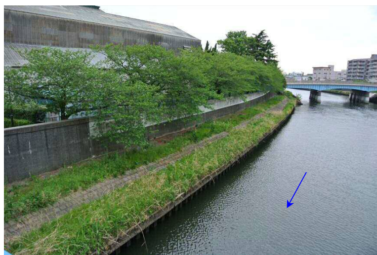
図 4-7 高水敷の現況（平成橋の下流付近。板橋区東坂下二丁目付近）
