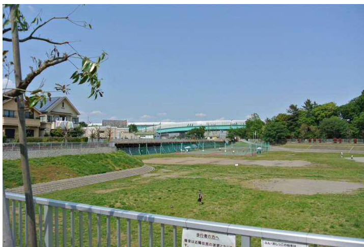
図 2-12 比丘尼橋上流調節池に設置された練馬区びくに公園多目的広場運動場 (練馬区東大泉二丁目付近)
