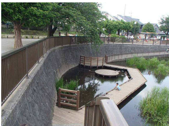
図 2-13 親水整備された大泉井頭公園 (練馬区東大泉七丁目及び南大泉四丁目)
