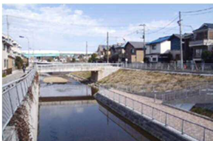
図2-15 親水整備された護岸（練馬区東大泉付近）
