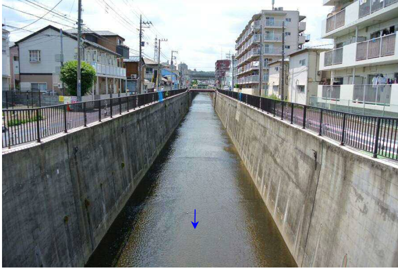
図 4-14 大成橋上流 の状況。東埼橋まで落差 工が続く。(板橋区成増三丁 目付近)
