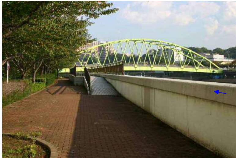
図 4-8 管理用通路の嵩上げ、緑化、遊歩道整備の状況 (新河岸大橋上流左岸。北区浮間五丁目付近)
