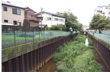
白子川:未整備区間(大泉学園町付近)
