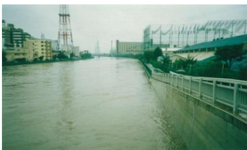
新河岸川西台橋付近の増水(平成 3年9月19日)
