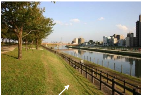
新河岸川の緩傾斜護岸（荒川赤羽桜堤緑地）
