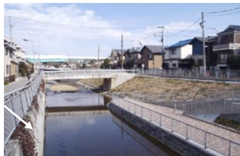
白子川：練馬区東大泉付近(親水整備区間)
