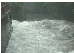
大雨時の蛇崩川合流点
