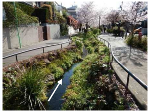
北沢川 (暗渠区間：緑道)
