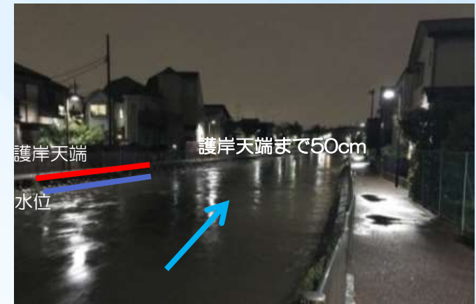
水位上昇状況（善福寺川 西田端橋）
