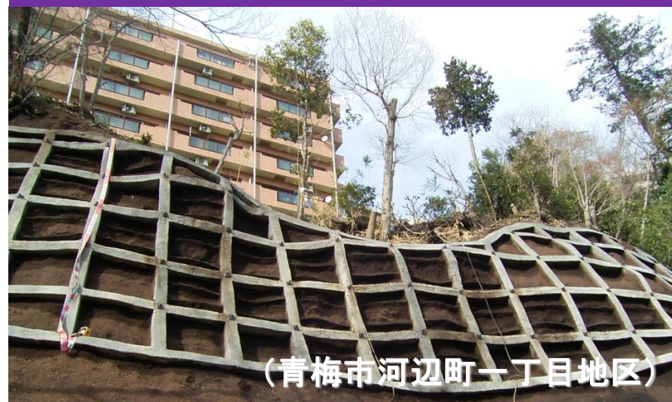
急な斜面を保全する法枠工
