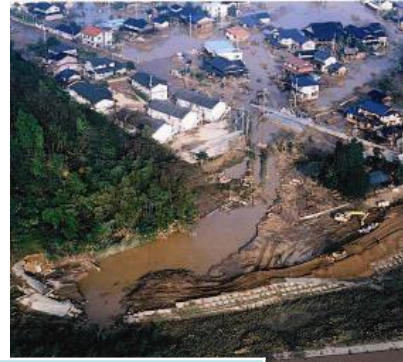
堤防決壊等に伴う洪水氾濫流による家屋倒壊等
