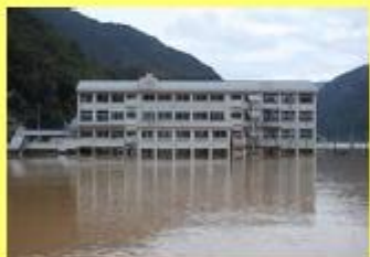
H26.8避難所2階の浸水 (徳島県)
