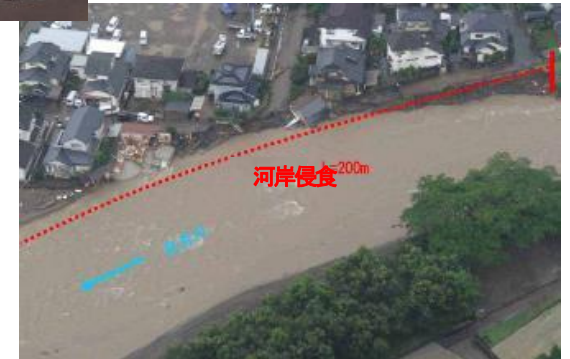
河岸侵食に伴う家屋倒壊等
