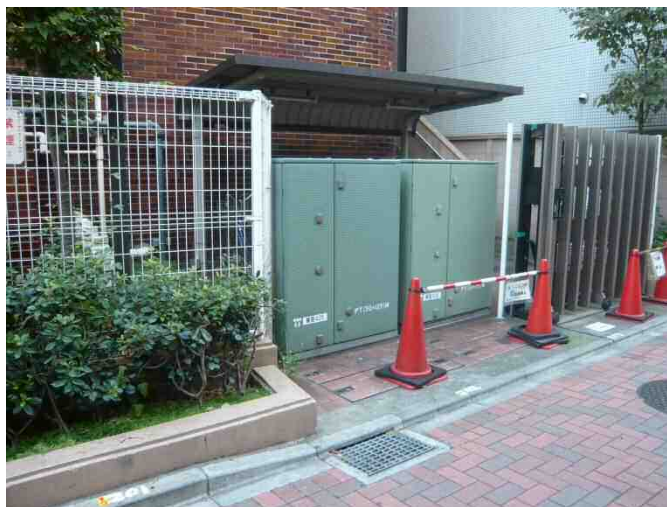
図 3-9 公共用地等への地上機器設置事例
