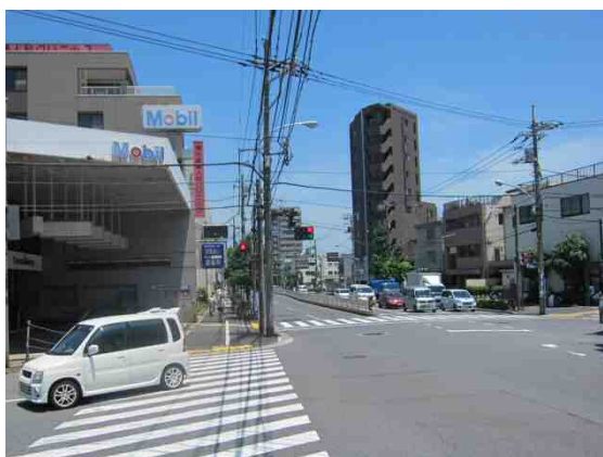
図 1-1 林立する電柱と輻輳する電線
