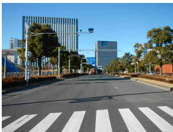
図 3-1716 臨港道路等の無電柱化の事例（臨海副都心）
