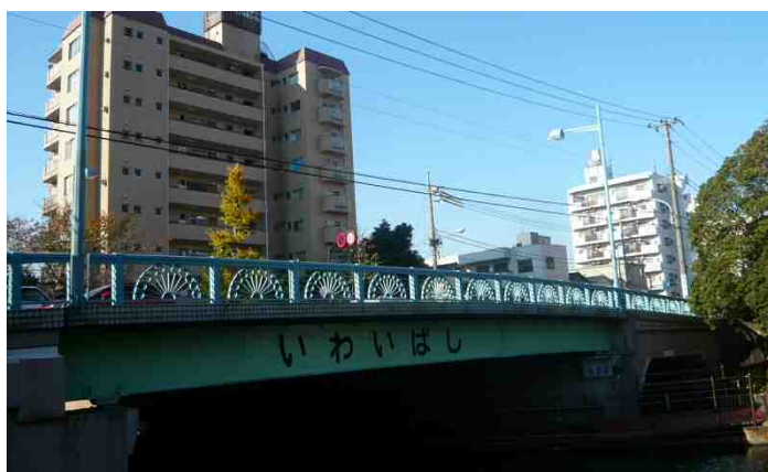
図 4-10 橋りょう部架線状況
