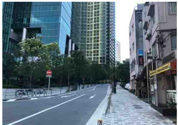
図 2-8 開発プロジェクトに合わせて無電柱化された事例
