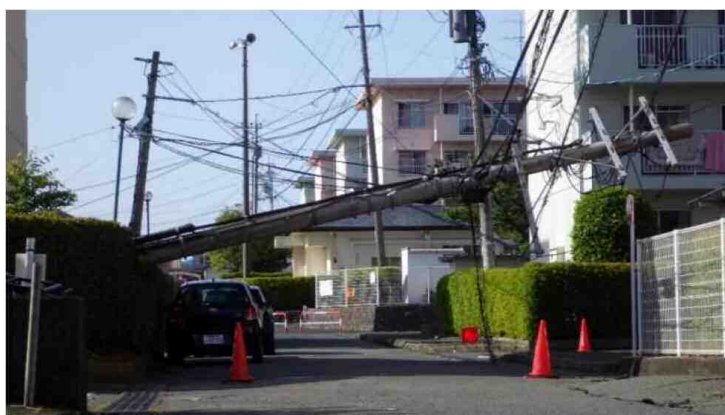
図 1-2 熊本地震による電柱の倒壊
