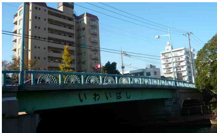
図 5-6 橋りょう部架線状況（清洲橋通り<江東区南砂>）
