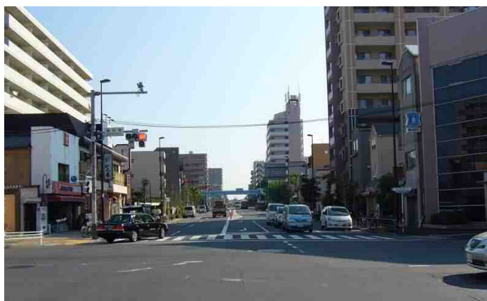
図 5-5 信号用ケーブル（清洲橋通り <江東区北砂>）
