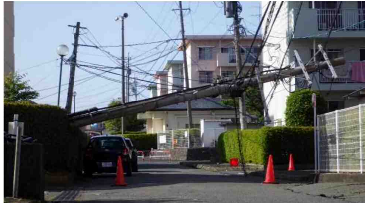
図 熊本地震による電柱の倒壊
