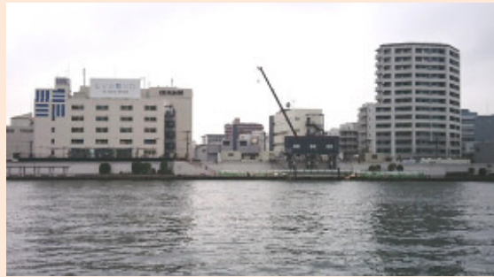
清澄排水機場
