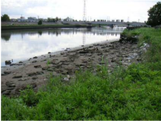
新中川低水護岸整備【整備前】
