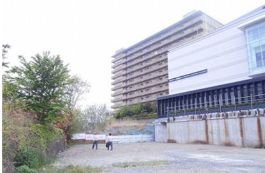
隅田川（神谷三丁目地区）【築堤一部完了】
