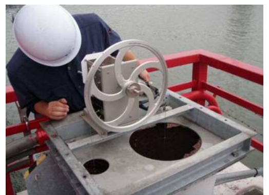
フロート式水位計点検
