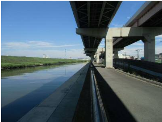
綾瀬川（四ツ木橋上流左岸）【施工前】
