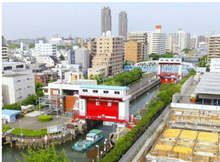
扇橋閘門の全景
