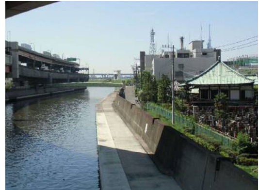
綾瀬川（新水戸橋下流右岸）【施工前】
