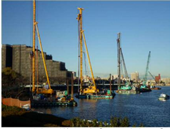
中川護岸耐震補強工事【地盤改良施工中】
