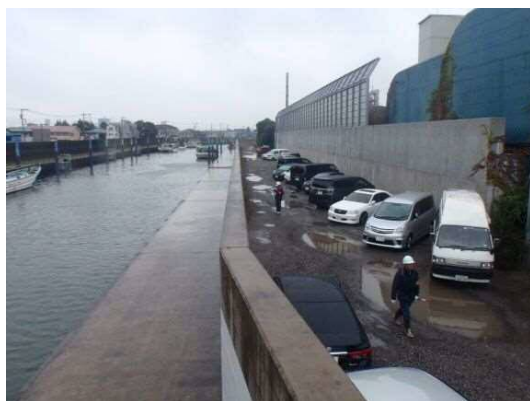
旧江戸川（妙見島）防潮堤耐震補強工事【施工前】
