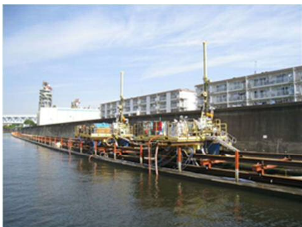
隅田川防潮堤耐震補強工事【地盤改良施工中】
