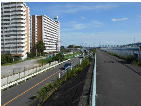
西新小岩地区（上流工区）【施工前】
