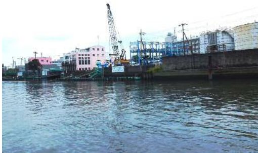
旧江戸川（妙見島）【施工前】
