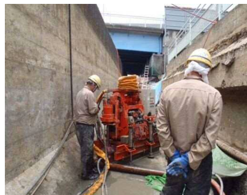
旧江戸川防潮堤耐震補強工事【地盤改良施工中】
