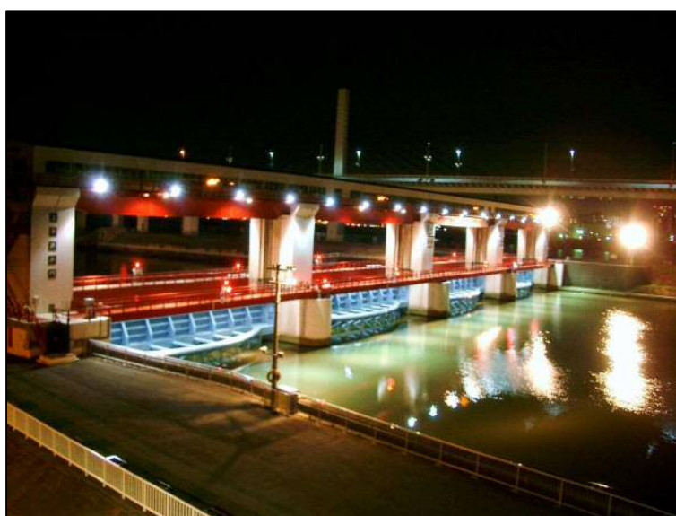
東日本大震災で閉鎖した上平井水門（夜間）
