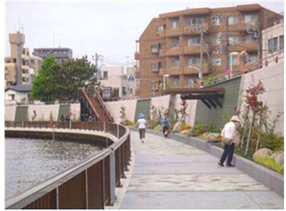
中川護岸（七曲区間）【施工後】
