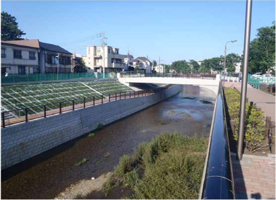
石神井川の護岸整備 (練馬区石神井台二丁目付近) ～緩傾斜護岸と上御成橋の完成 平成28年3月～
