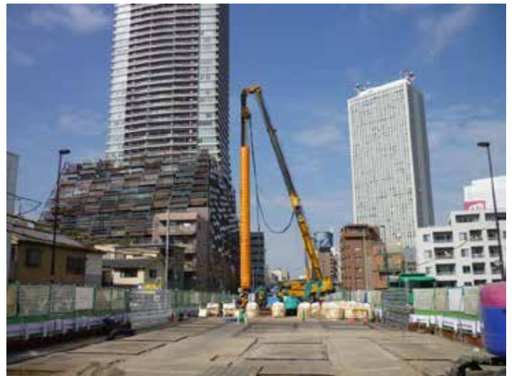
豊島区南池袋二丁目付近(東通り付近から北側を望む) ～ 平成27年度より豊島区役所付近の地下道路工事に着手 ～
