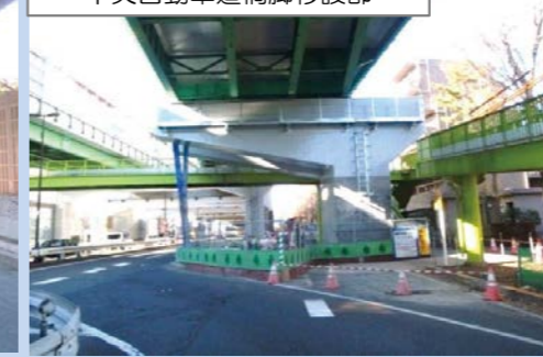
中央自動車道橋脚移設部
