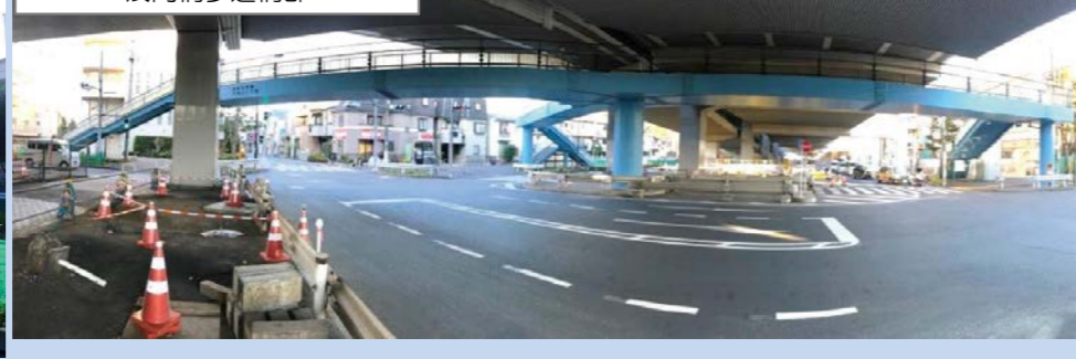
浅間橋歩道橋部
