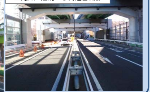
上高井戸陸橋から側道合流部
