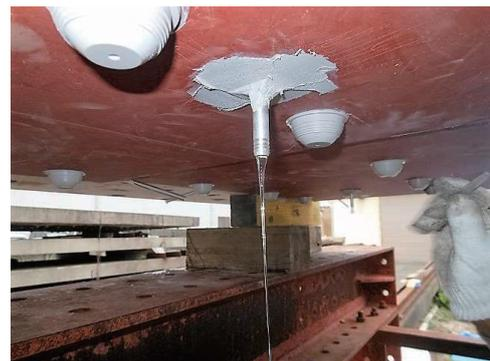
(c) 接着材の注入(空気抜き)
