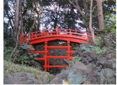
図2-97 通天橋 (平成29年2月4日)
