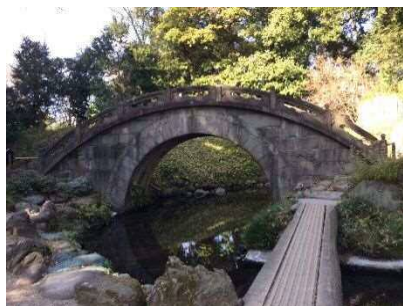
図2-41 H：円月橋の景観 （平成29年1月6日）
