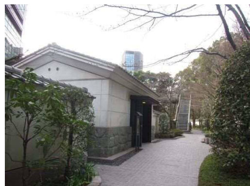
図2-29 小石川後樂園展示室 (平成29年3月24日)
