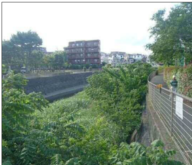
現在の河道内樹木の繁茂状況 (西田スポーツ広場前;金山橋上流)
