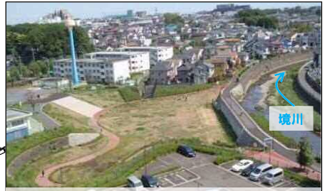
鶴金橋上流遊水地の全景
