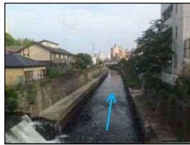
藤沢橋ネック区間
