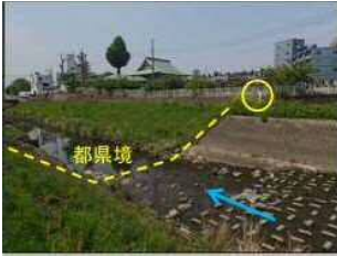
鶴瀬橋上流(未整備)
