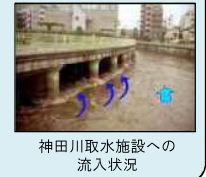
神田川取水施設への流入状況
