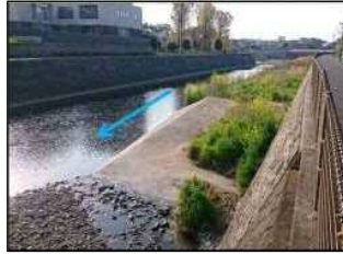
鶴間一号橋付近
