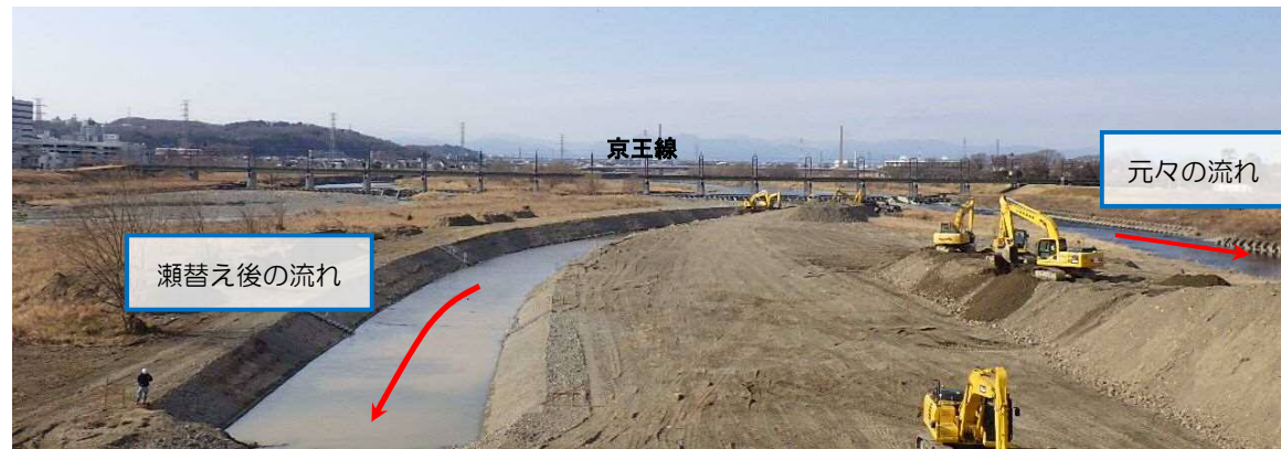
瀬替え作業状況 (関戸橋から上流側に向かって撮影)
