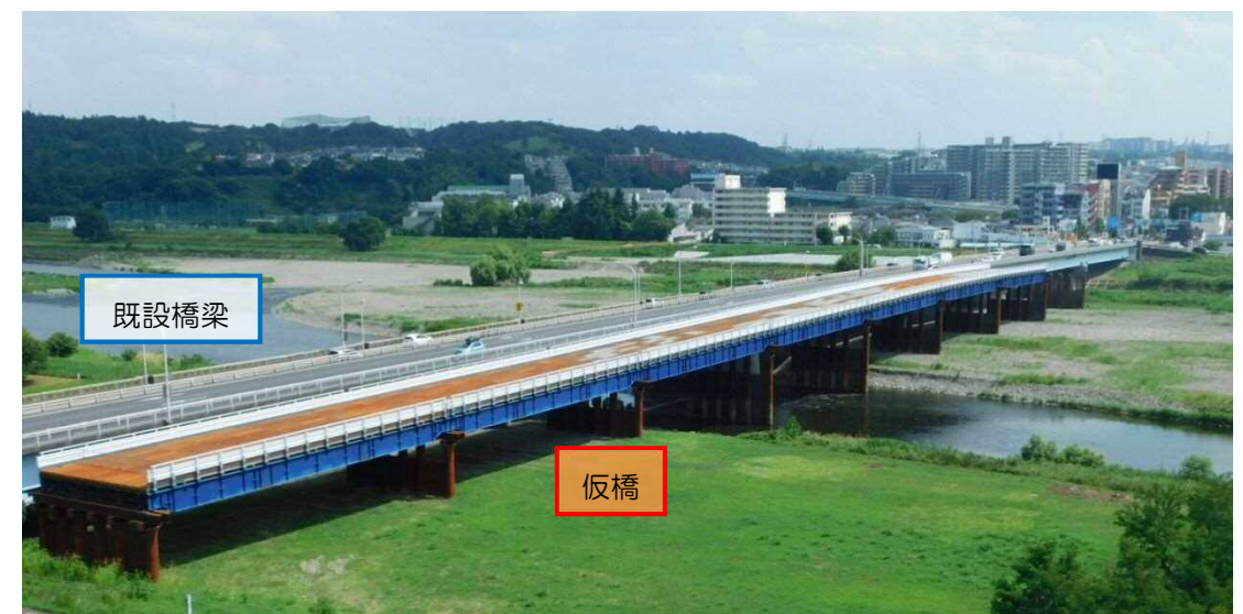
仮橋工事2年目完了後の状況（府中市側から多摩市側を望む）
