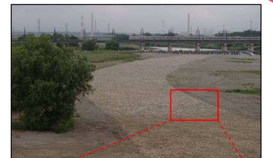
再生した礫河原の様子 (関戸橋から上流側を望む)
