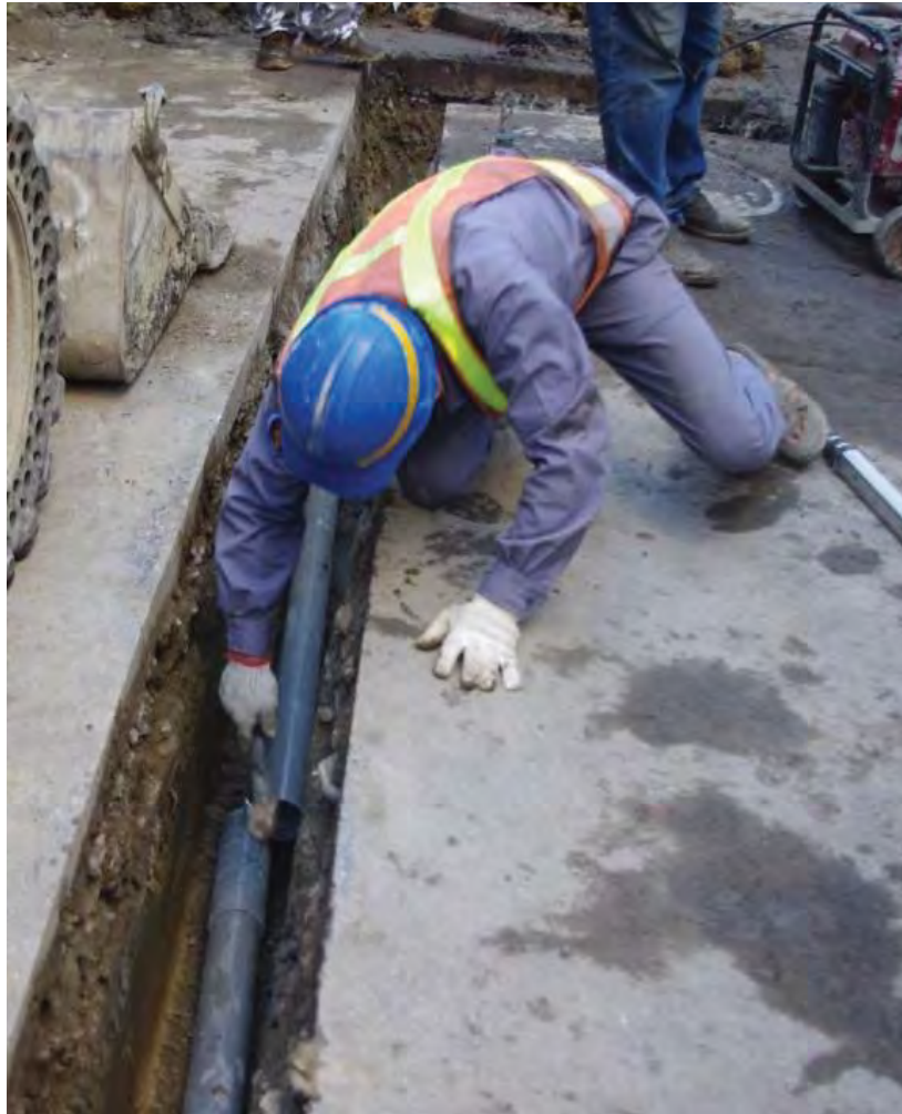
台湾：掘削を浅く狭くし、掘削土量を削減
