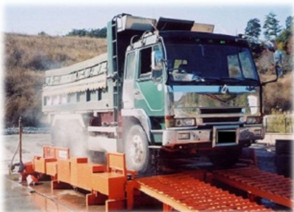
工事現場内での車両洗浄 イメージ
