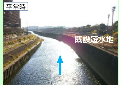
④ 二級河川柏尾川(横浜市栄区) 金井遊水地付近
