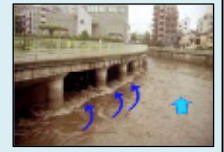
神田川取水施設への流入状況
