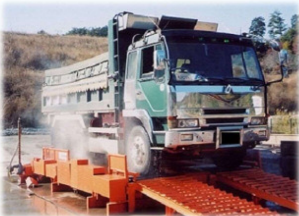
工事現場内での車両洗浄 イメージ
