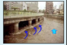
神田川取水施設への流入状況
