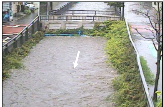
平成25年7月豪雨における増水状況 (谷沢川・丸山橋付近)
