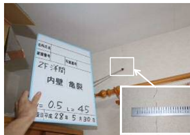
【 屋内の壁面調査 】
