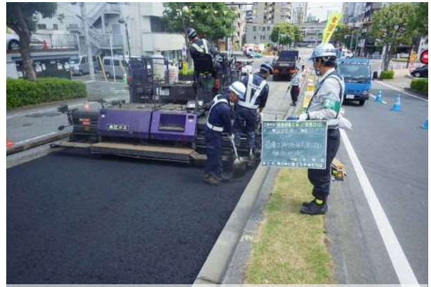
②アスファルト敷均し
