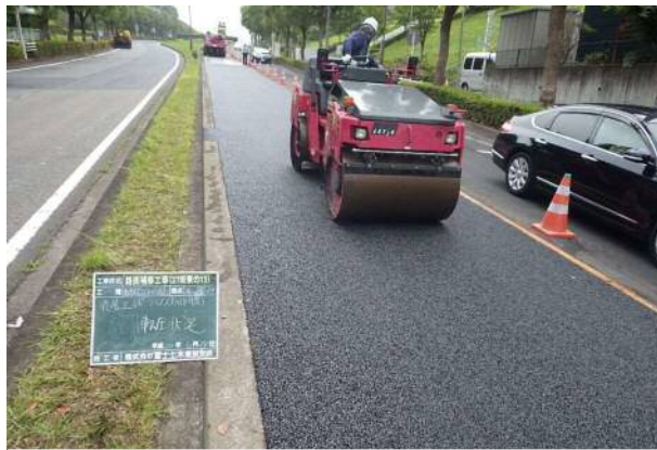
③アスファルト舗装転圧
