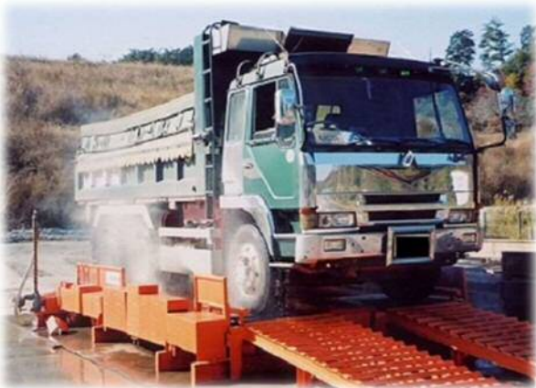
工事現場内での車両洗浄 イメージ
