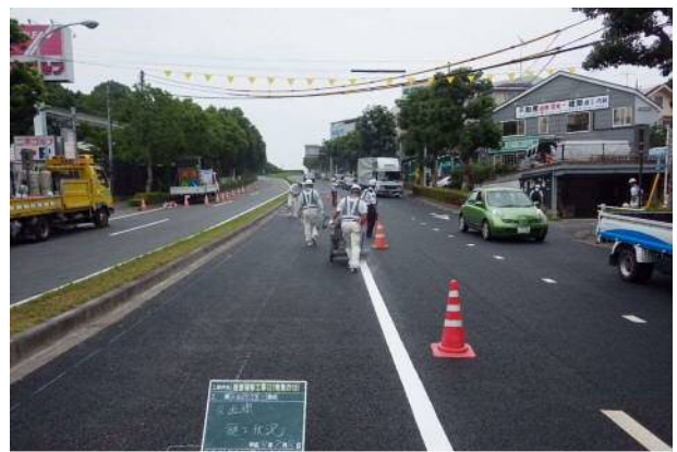
④区画線施工
