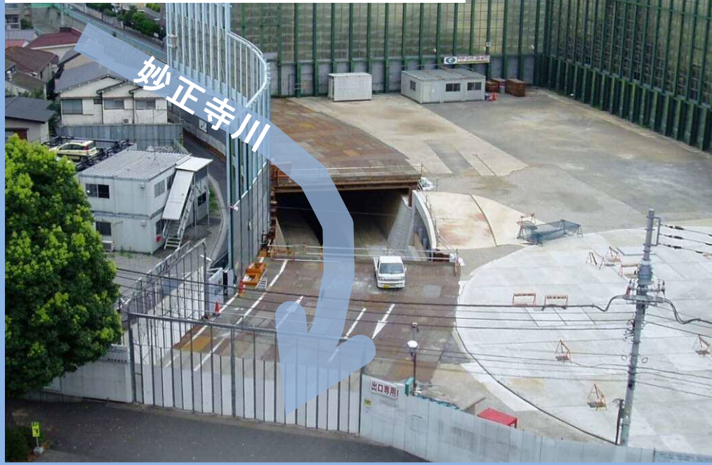
妙正寺川の上部に栈橋を設置
