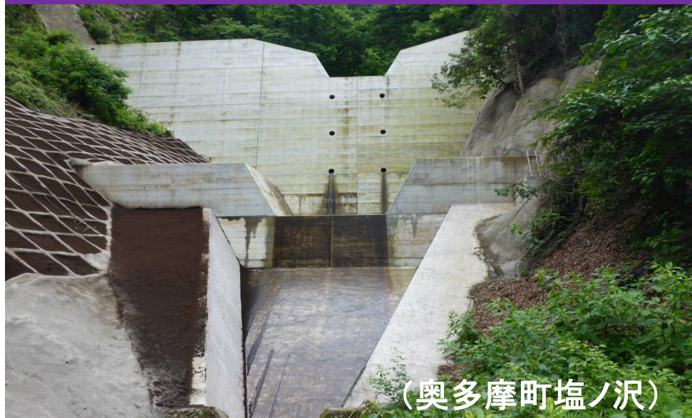
土石流を抑える砂防えん堤
