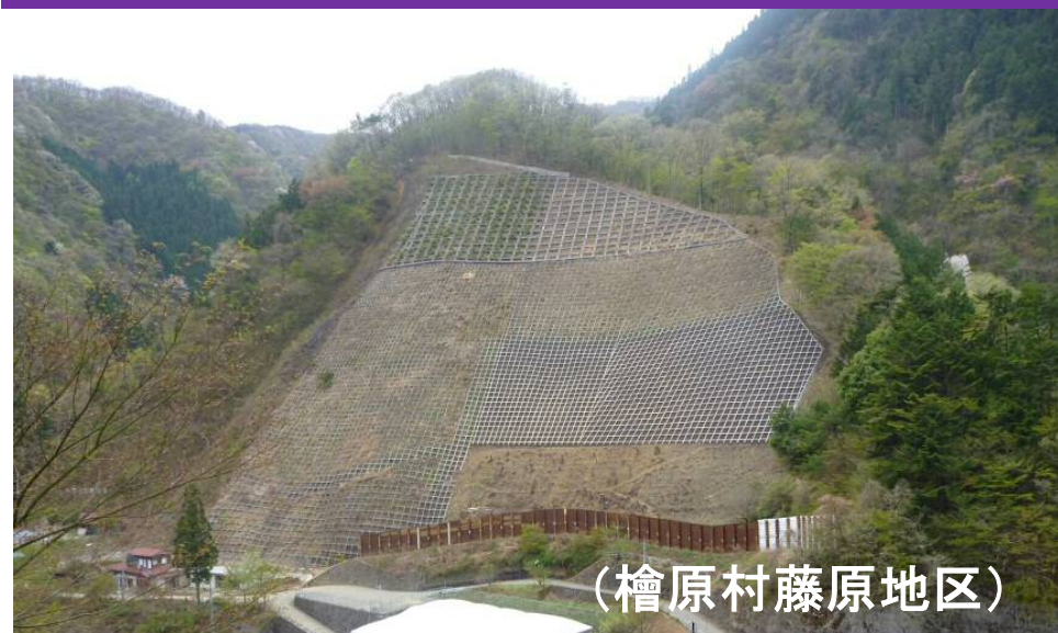
急な斜面を保全する法砕工
