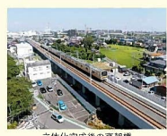
立体化完成後の高架橋
