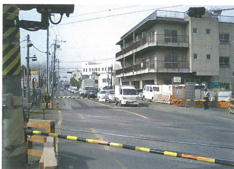
工事着手前(大丸踏切)
