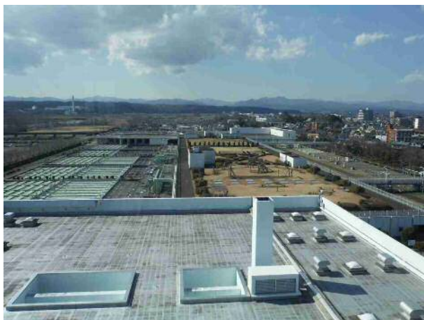
展望台から第一沈殿池と第二沈殿池
