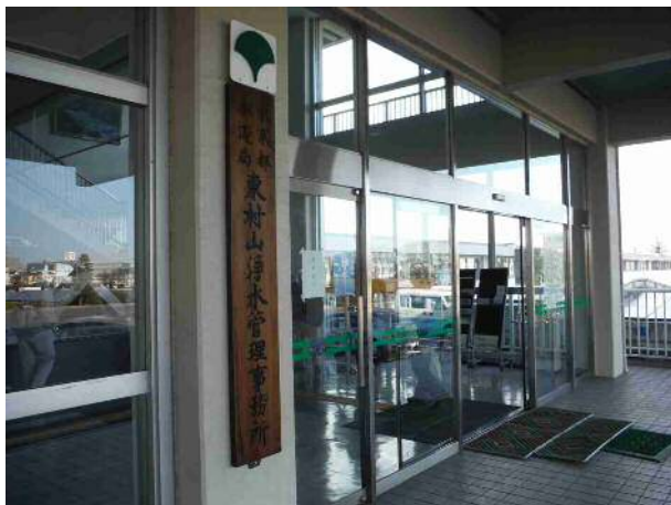
東村山浄水場
