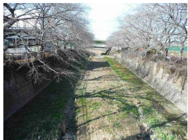
残堀川 (上水橋上流)
