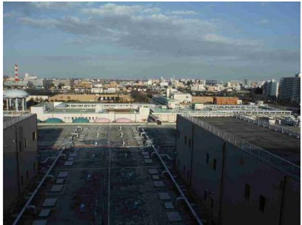
展望台よりろ過池、薬品タンク、配水池等
