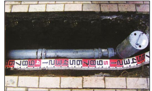
【衝撃に強い硬質塩化ビニル管への取替え】
