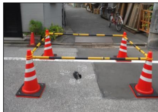
【取付管による道路陥没事例】
