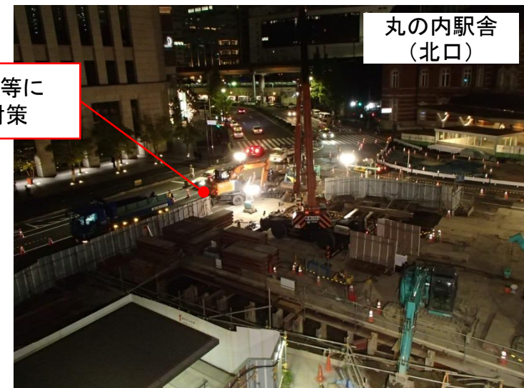
開削工法による掘削状況
