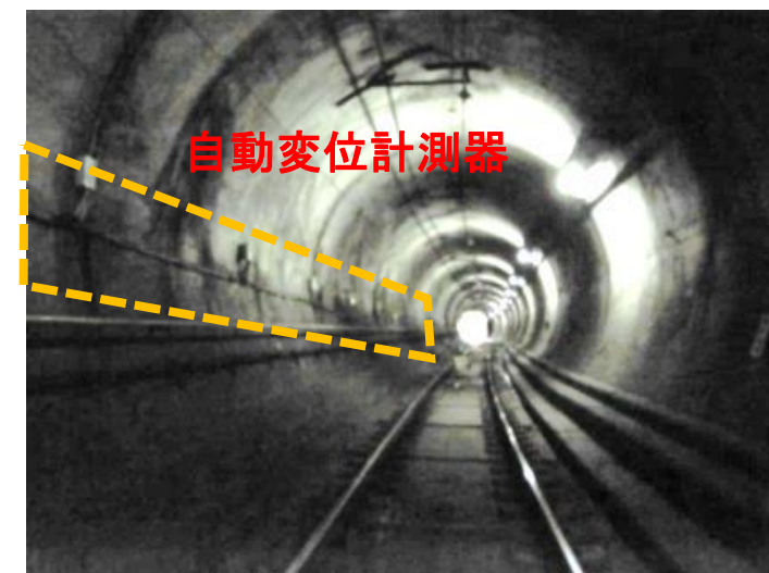
トンネルの計測管理状況
