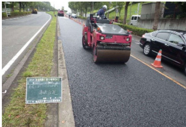
③アスファルト舗装転圧
