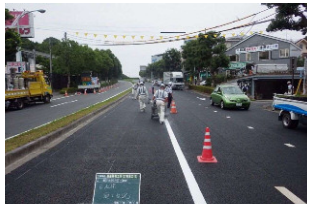
④区画線施工
