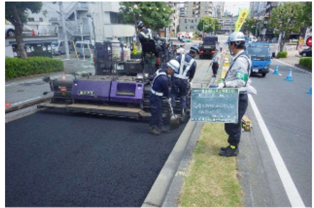
②アスファルト敷均し
