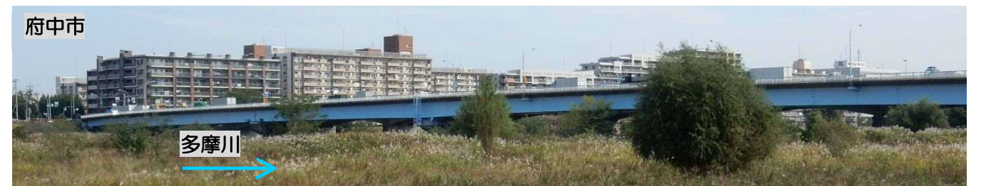
多摩川上流より関戸橋上流橋を望む
