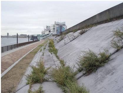
写真-4 遮熱性塗料塗布箇所（東小松川）
