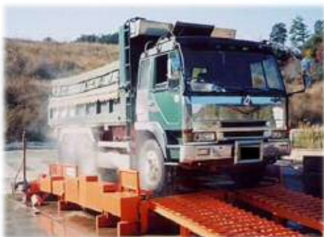
工事現場内での車両洗浄 イメージ
