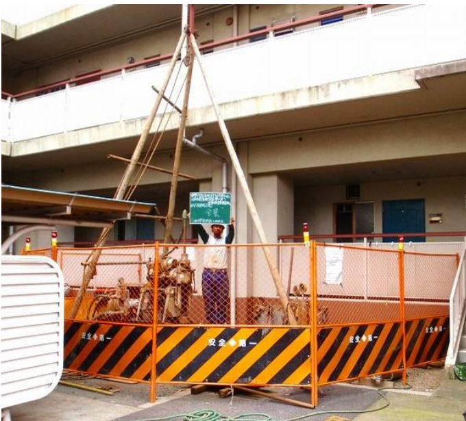
<ボーリング状況例>
