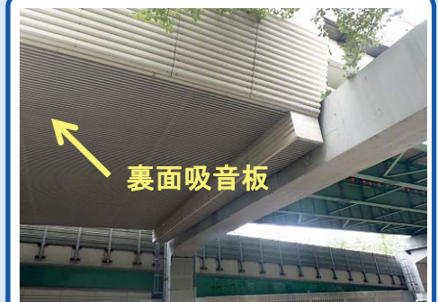
写真3：裏面吸音板の設置例
