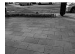
景観舗装(天然石舗装・銀座)
