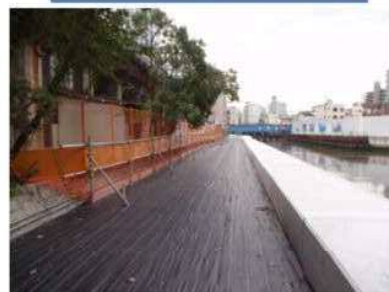
被覆コンクリート施工後
