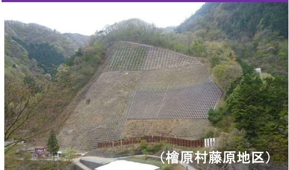
土石流の流れる方向を制御する導流堤
