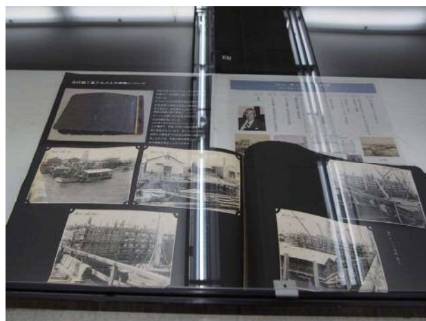
写真-4 永代橋の工事アルバム
